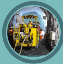
Galería de Acceso, en el Portal de Entrada.
